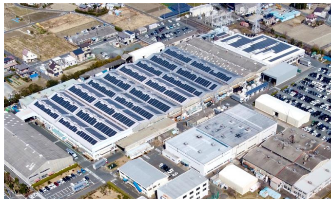
(THK リズム株式会社浜松工場 静岡県浜松市 発電容量：1,829.52kW)
