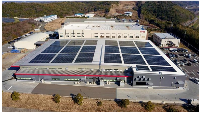
(THK リズム株式会社九州工場 大分県中津市 発電容量：834.57kW)
